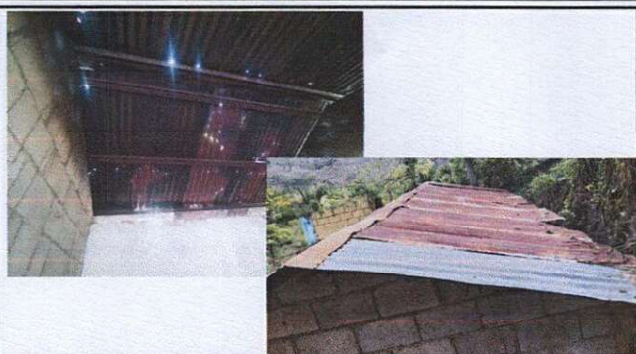
Sustitución de cubierta de lámina en mal estado, en el área de cocina y las aulas.
