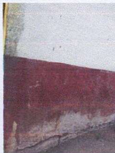
Foto 6: Mejoramiento de repello en el pared de los servicios sanitarios.
